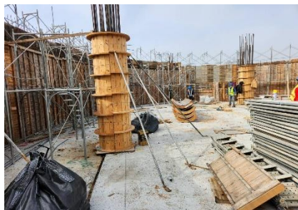
鋼筋/模板施工
